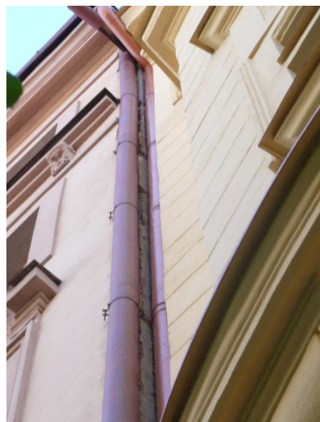
17 – DEŠŤOVÝ SVOD HORNÍ PODLAŽÍ – nekvalitní provedení detailu za svodem
